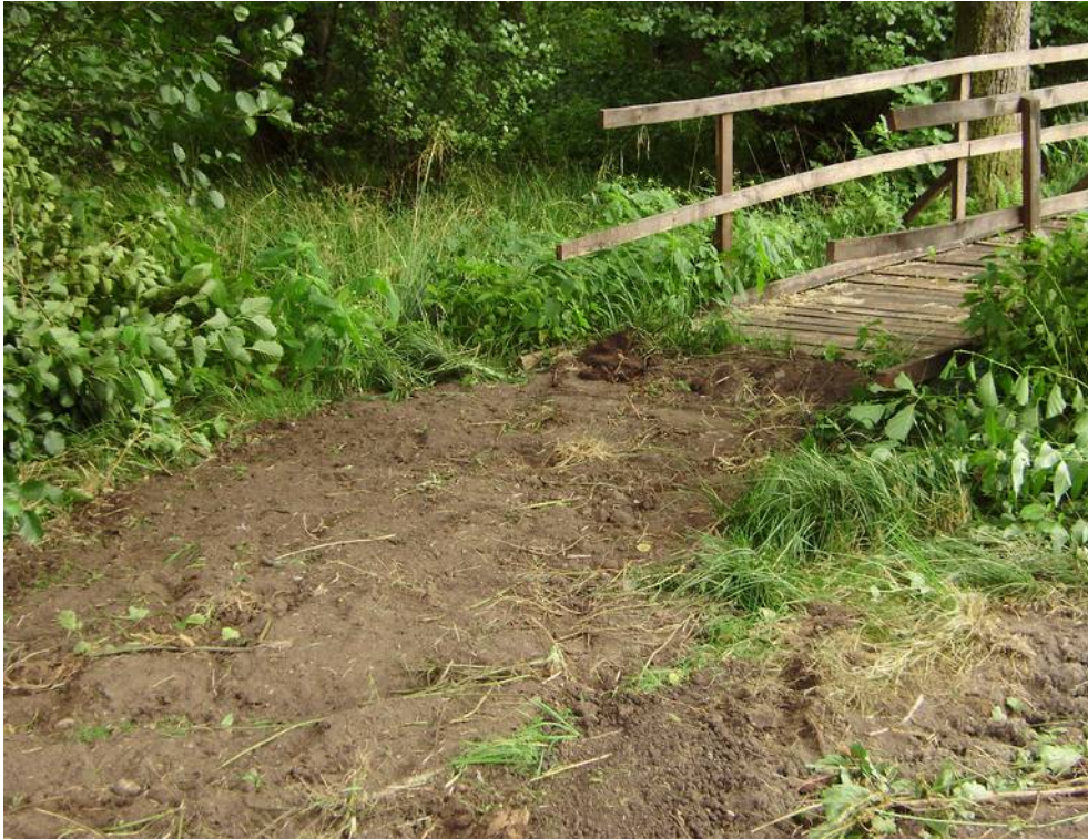
Dammvallen ansluter här till den befintliga spången.
