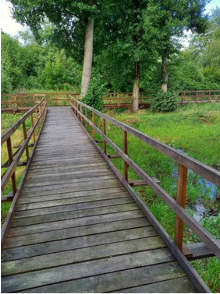
Bron och den nya spången har här oljats färdigt. Foto 7 september
