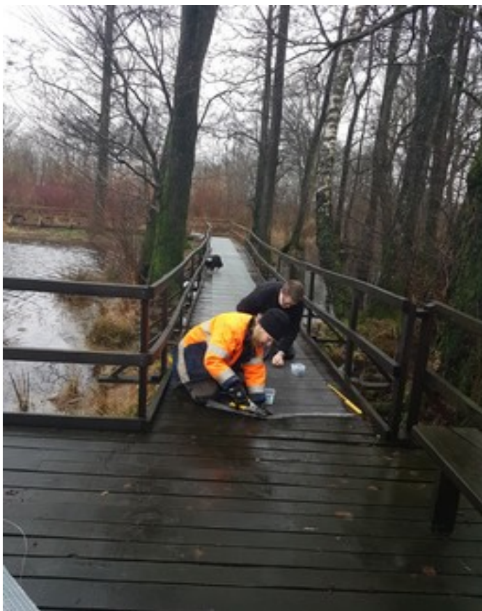
Lena och Tommy spikar fast nätet på spången. Då var det mycket vatten i dammen. Foto 1 februari 2020
